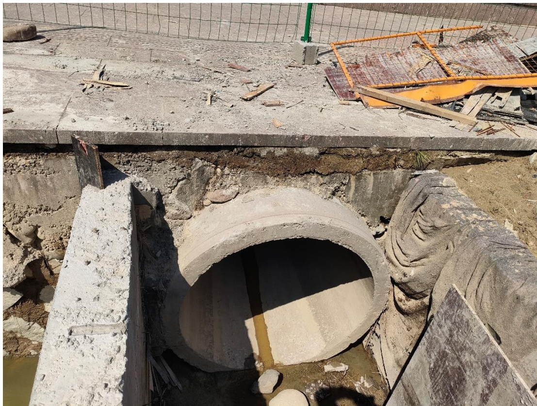
图 6.2-6 贤良路排洪渠出口
