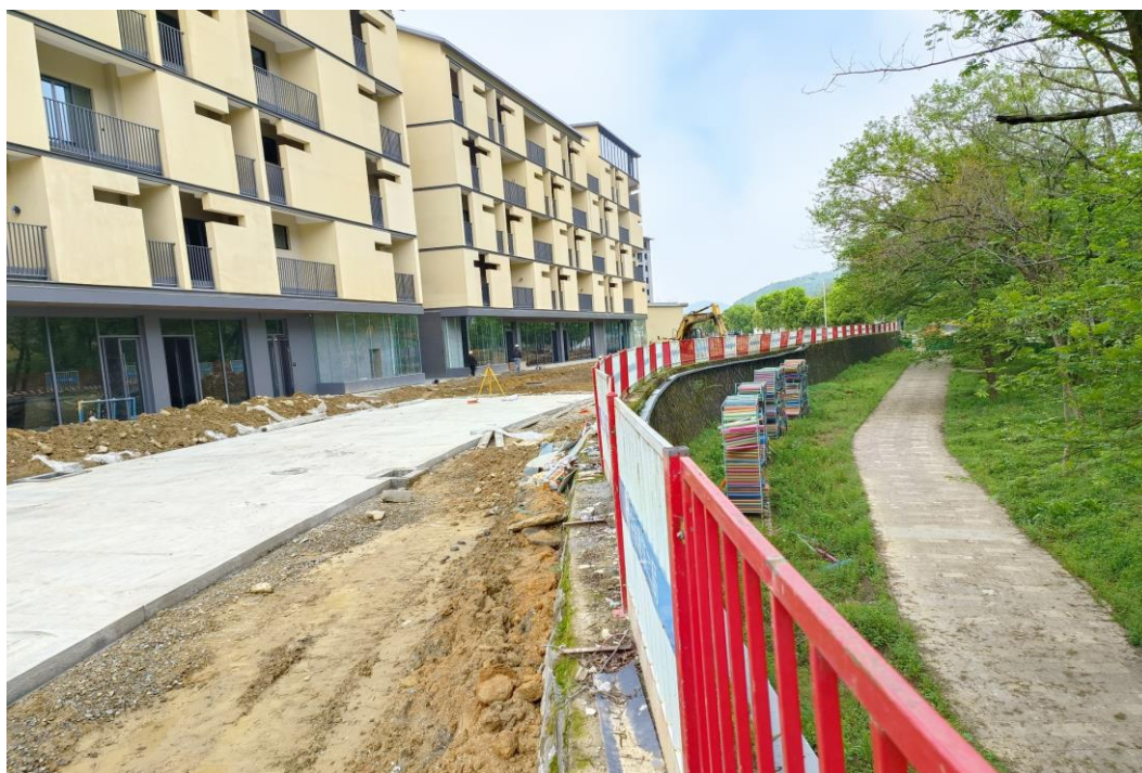
图5.2-8 秦溪漠段防洪堤顶
