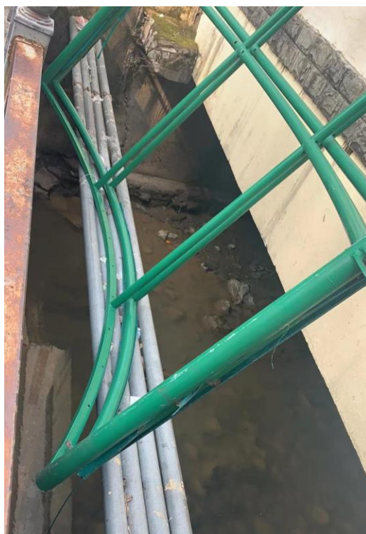
图 6.2-6 金沙排洪渠水南小学桥下游
