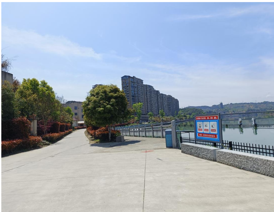
图5.2-4 河村段防洪堤顶
