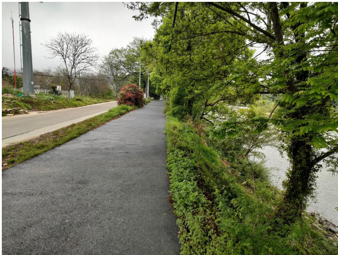
图5.2-2 炉田段防洪堤顶
