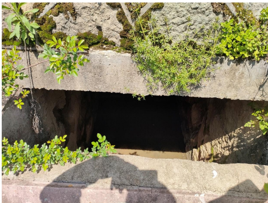
图 6.2-5 文化巷排洪渠出口
