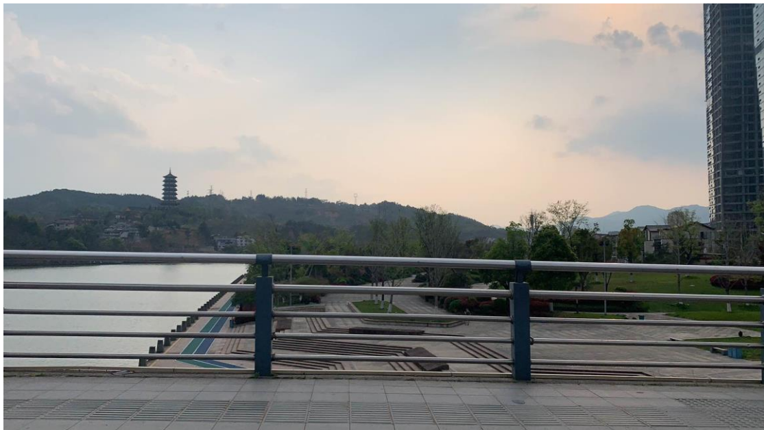
图5.2-13 主城区北岸防洪堤顶
