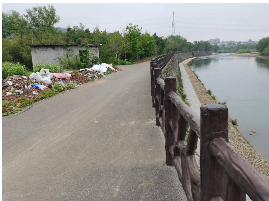
图5.2-19 临江段防洪堤顶
