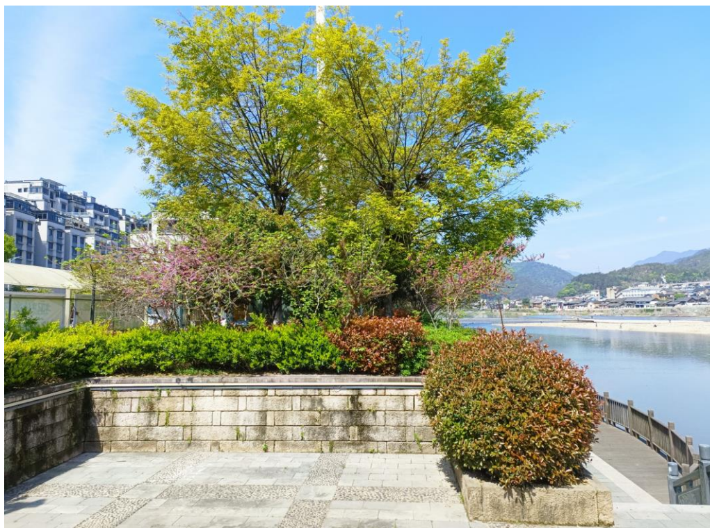
图5.2-10 主城区南岸防洪堤顶
