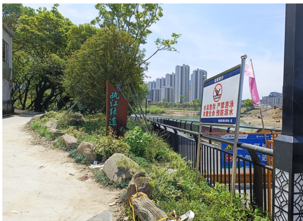
图5.2-17 武潭段防洪堤顶
